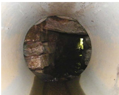
Figur 8: Stikkrenne som er forlenget
