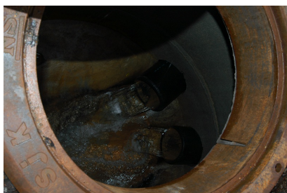
Kum i tunnel. Foto: Kjell Wold
