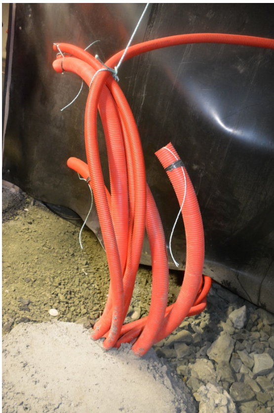
Trekkerør i bankett. Foto: Tore Paulsen
