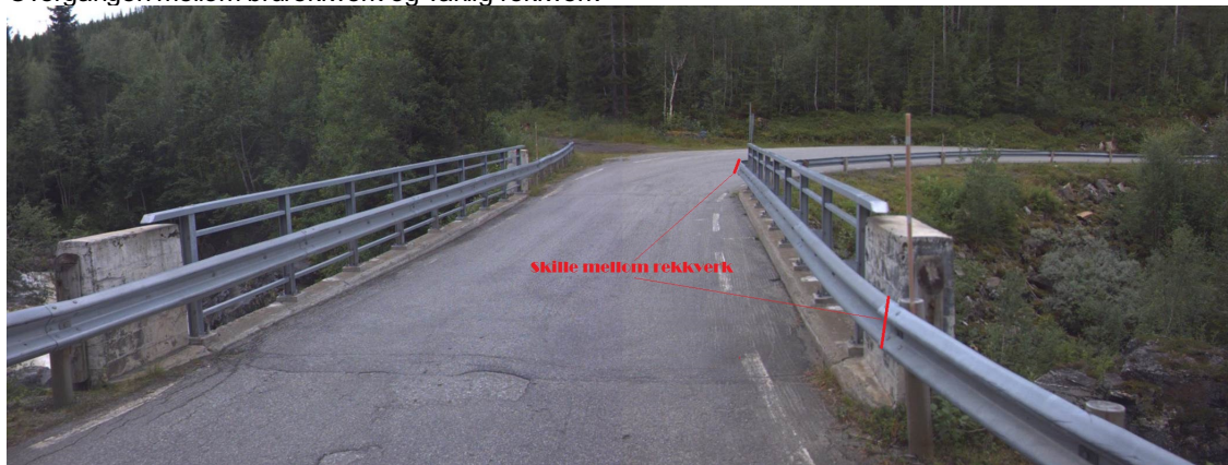
Rekkverk på/ved bru. Foto: Statens vegvesen
