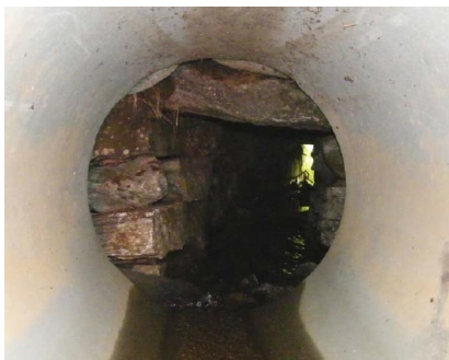
Figur 8: Stikkrenne som er forlenget
