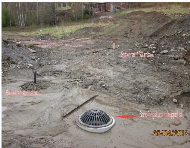
Sandfangskum, bakkekran og stakerør. Foto Terje Rønneberg
