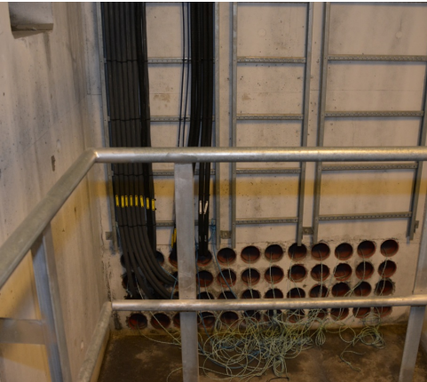
Trekkerør inn til hovedfordeling. Foto: Tore Paulsen
