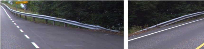
Nedføring i bakken med og uten utsvinging
