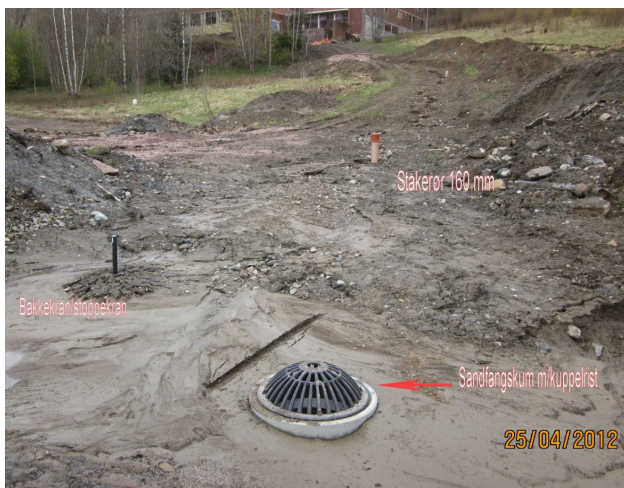
Sandfangskum, bakkekran og stakerør. Foto Terje Rønneberg
