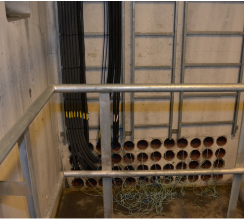
Trekkerør inn til hovedfordeling. Foto: Tore Paulsen
