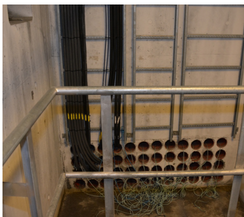
Trekkerør inn til hovedfordeling. Foto: Tore Paulsen
