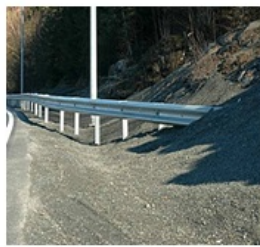
Sideforankring i mur og jordskjæring
