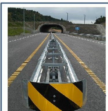
Avslutning i støtpute (Støtpute er eget objekt i Datakatalogen)
