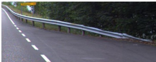
Nedføring i bakken med og uten utsvinging
