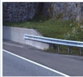
Sideforankring i mur og jordskjæring
