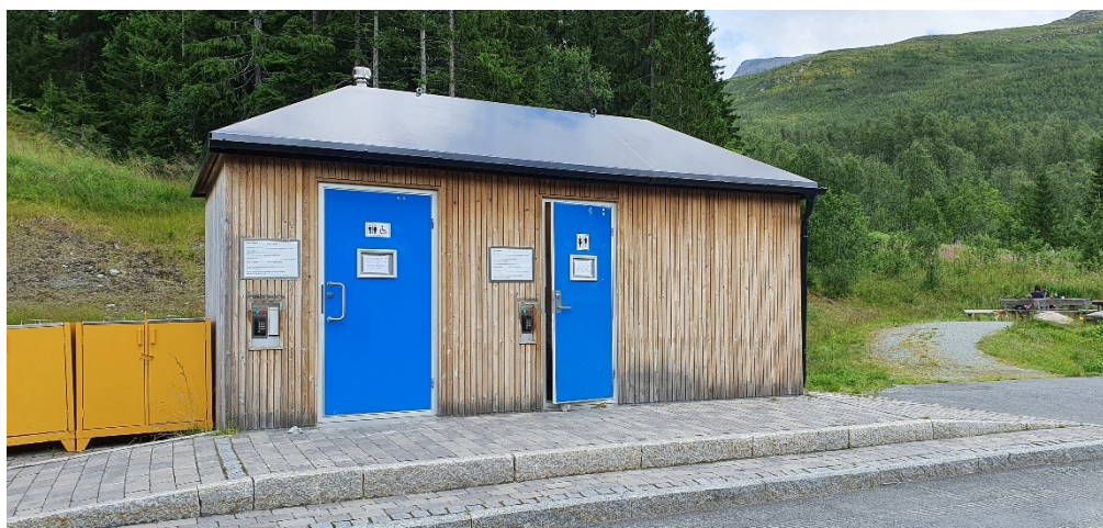
Figur 1 Toalettanlegg (Foto: Randi Skoglund, Statens vegvesen)
