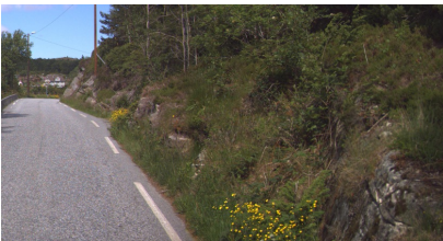
Foo: Statens vegvesen
