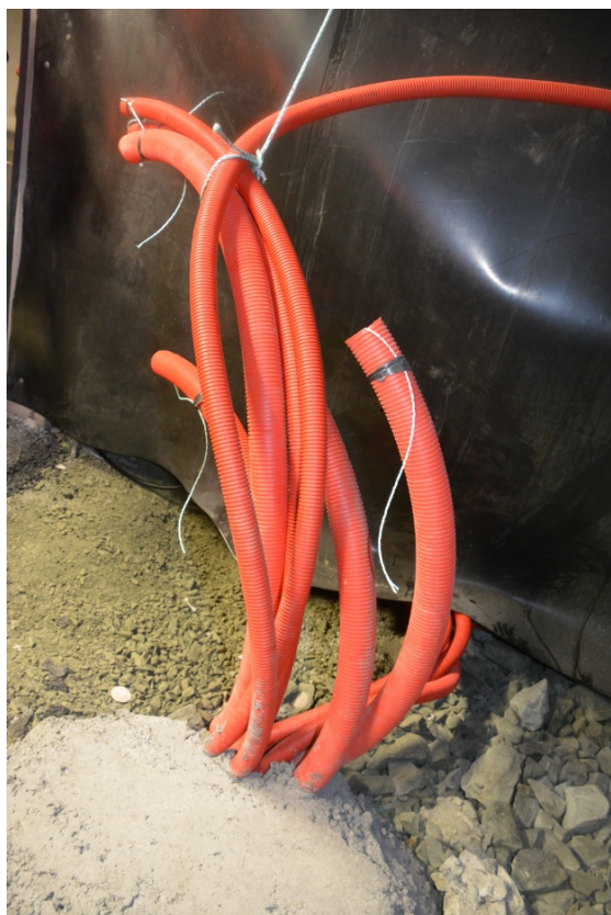
Trekkerør i bankett. Foto: Tore Paulsen
