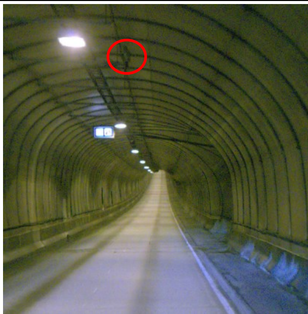
Foto: Statens vegvesen, Vegbilder
