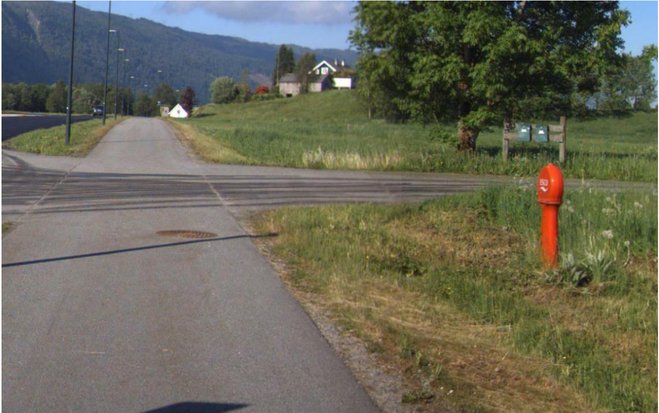
Figur 1 Brannhydrant til høyre i bildet (Foto: Vegbilder, Statens vegvesen)
