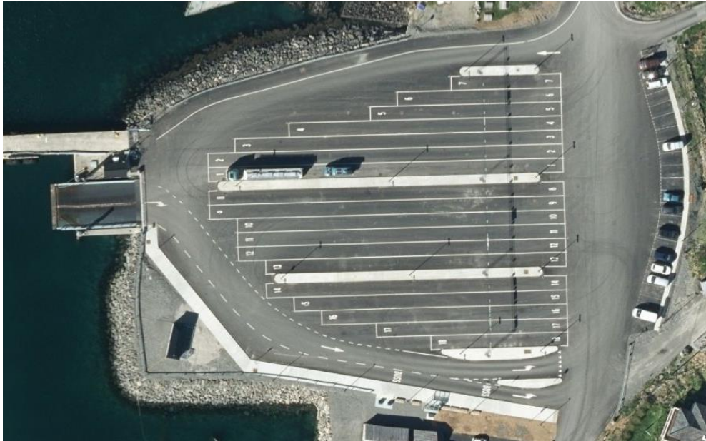
Figur 1 Ferjeoppstillingsplass (Foto: Fra Vegkart)
