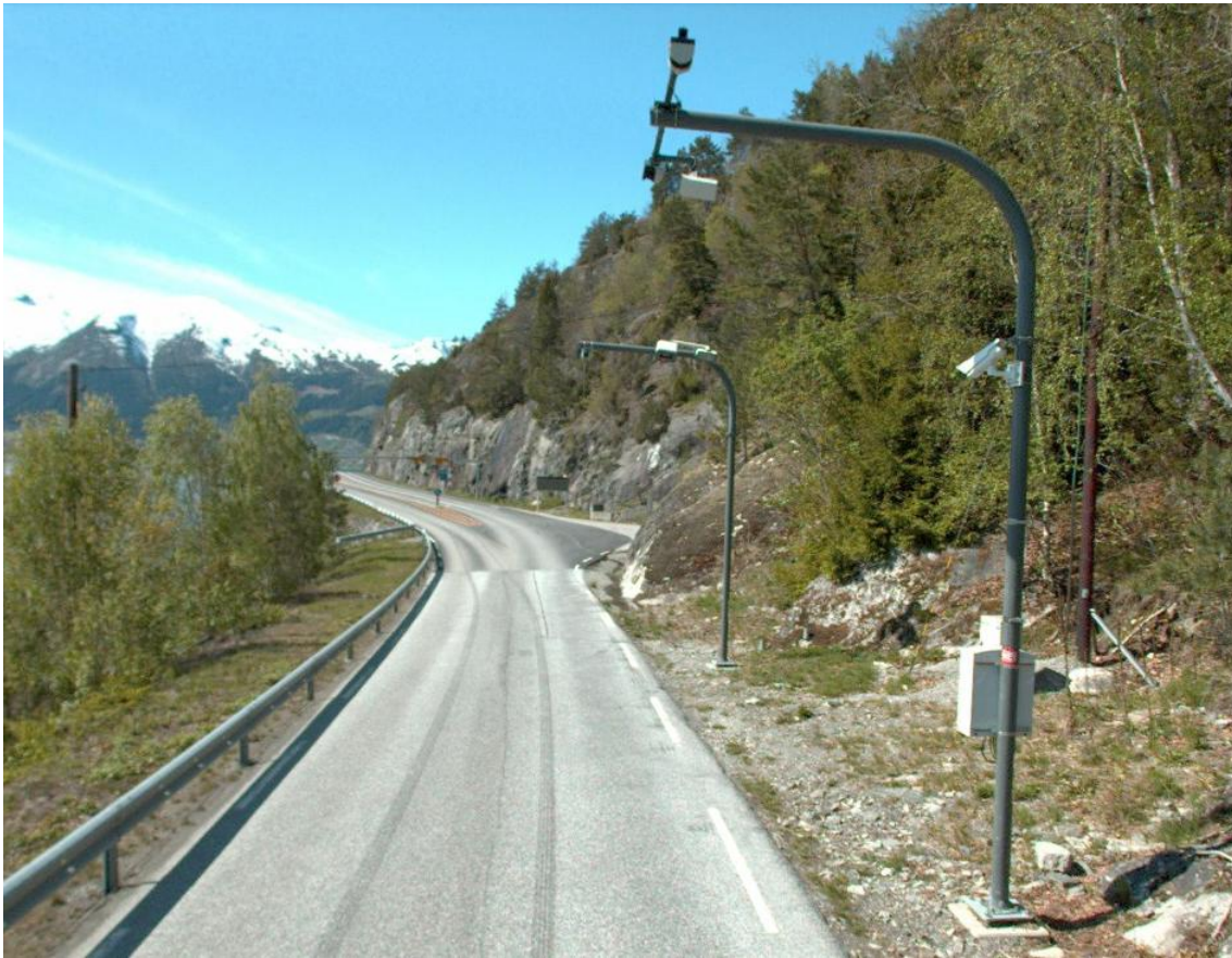
Foto: Vegbilder, Statens vegvesen
