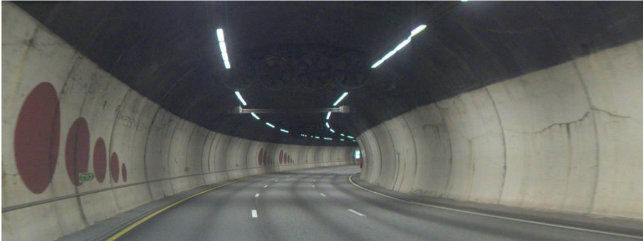
Figur 1 Betongutstøping i Festningsdelen av E18 Operatunnelen (Foto: Vegbilder, Statens vegvesen)
