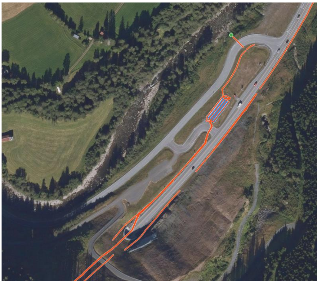
Figur 1 Vannhånderingsanlegg ved Soknedalstunnelen på E6 i Trøndelag (Foto: vegkart.no)
